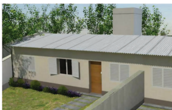
Frente NO vivienda entre medianeras
