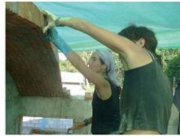
Figura 3. Una mujer trabajando en la construcción de la bóveda de ladrillo recargado en la comunidad de San Juan de los Ríos, en el departamento de Cauca, Colombia. El proceso de construcción de la clínica de salud en la comunidad de San Juan de los Ríos, en el departamento de Cauca, Colombia.
