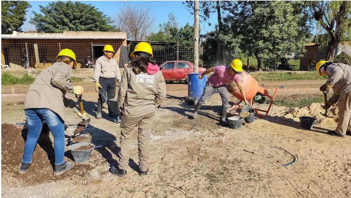
Figura 3: Ejecución de veredas perimetrales. Diciembre 2022. Fuente: Elaboración propia.
