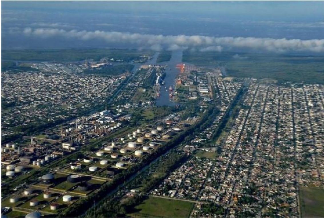
Fig. 1 Refinería YPF-La Plata. Fuente: Fuente: Diario Hoy, 26 de diciembre del 2020
