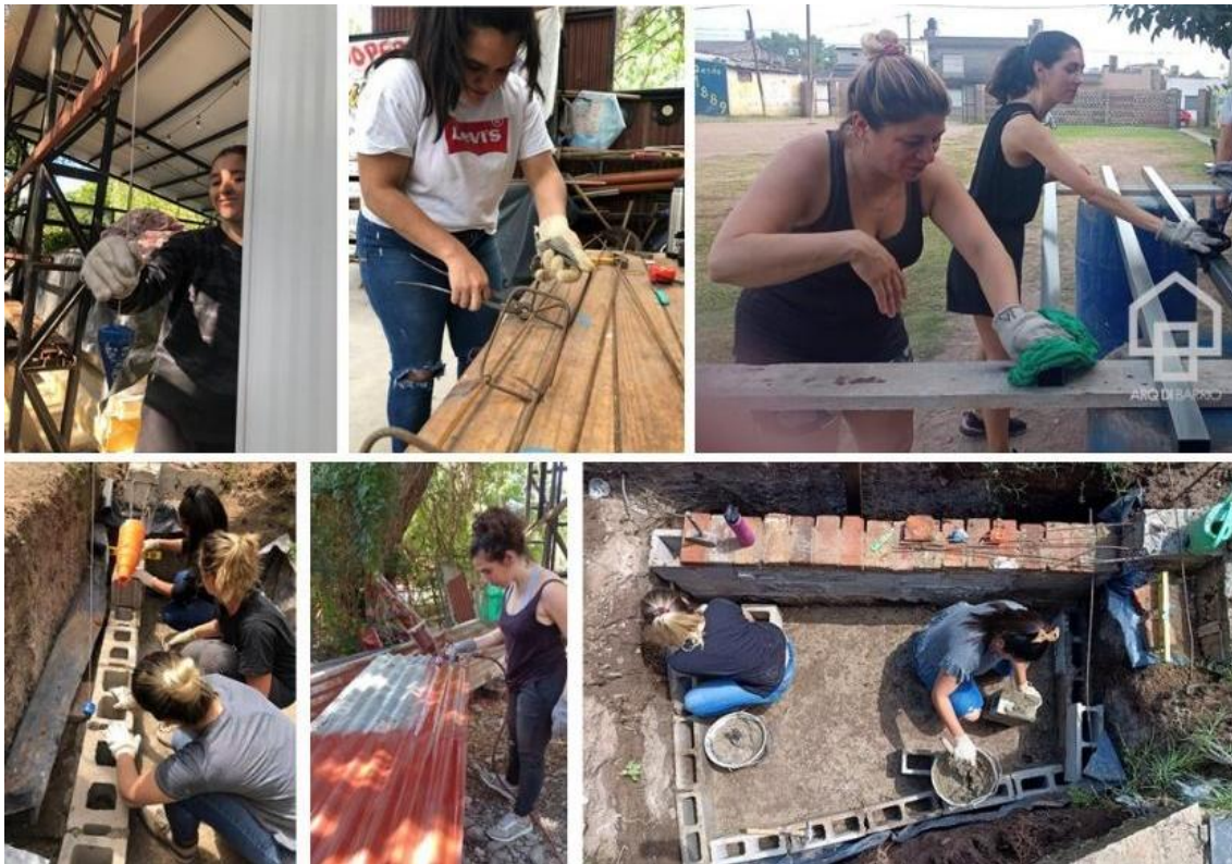
Figura 4: Estudiantes, docentes y vecinas trabajando en la obra.
