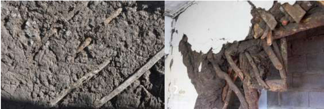
Figuras 5 y 6: Partes de muros donde se puede observar el tejido de varillas. Fuente: Foto izquierda Viviana Bordoli, foto derecha Alejandro Ferreiro
