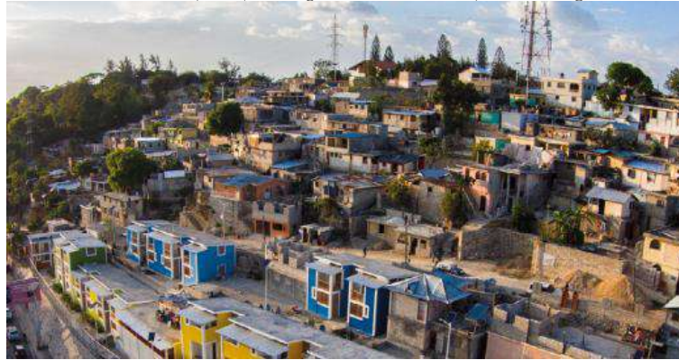
Figura 9: rehabilitación de más de 9.000 obras de viviendas e infraestructuras comunitarias de bajo costo. Fuente: UNOPS. El terremoto que sacudió Haití en 2010 provocó el derrumbamiento de cientos de miles de hogares. Se encargó a UNOPS la rehabilitación de más de 9.000 obras de viviendas e infraestructuras comunitarias de bajo costo. Durante la implementación del proyecto se adoptó un enfoque participativo basado en el uso intensivo de mano de obra a fin de conseguir crear oportunidades de empleo que incluyeran un fuerte componente de género.
