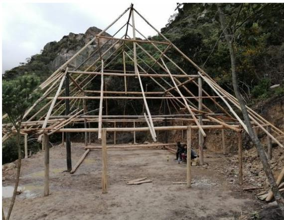
Imagen 1. Construcción de la maloca en el asentamiento del Cabildo en Usme, Bogotá.
