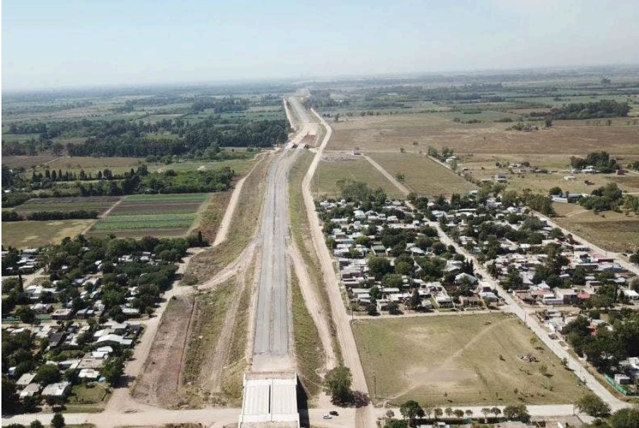
Figura 27: Camino del Buen Ayre. Construcción
