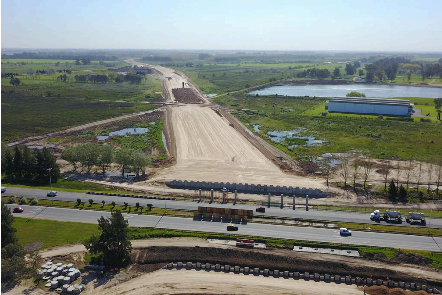
Figura 31: Camino del Buen Ayre. Construcción
