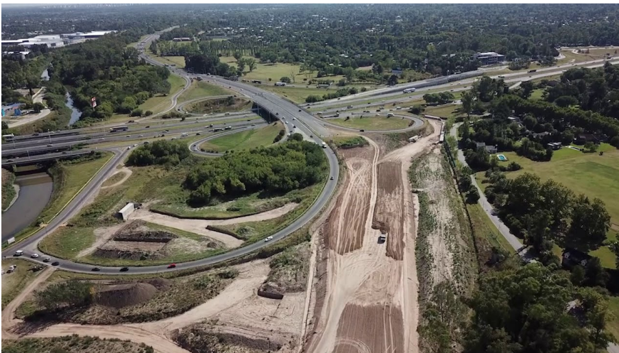
Figura 28: Camino del Buen Ayre. Construcción. Intersección con Acceso Oeste
