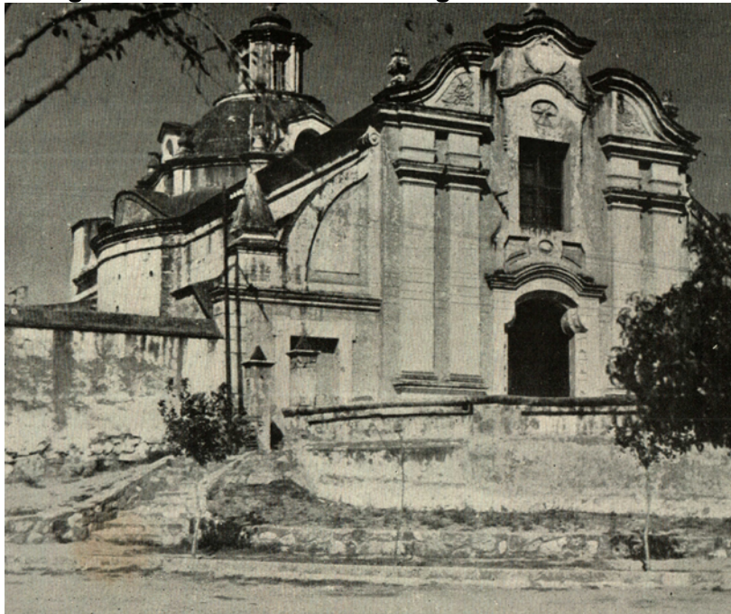
Fotografía 1: Fachada exterior Iglesia de Alta Gracia
