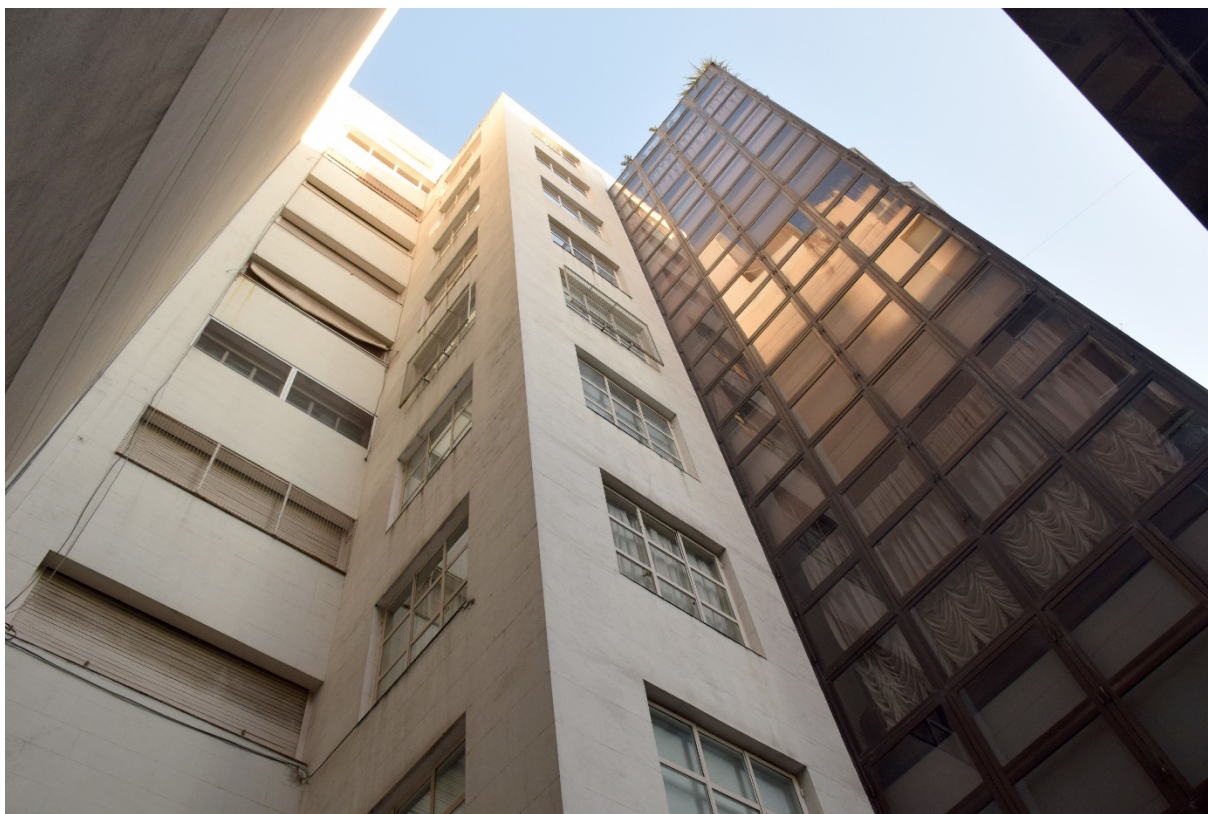
Figura 5: Fachada de Ugarteche 3143.
