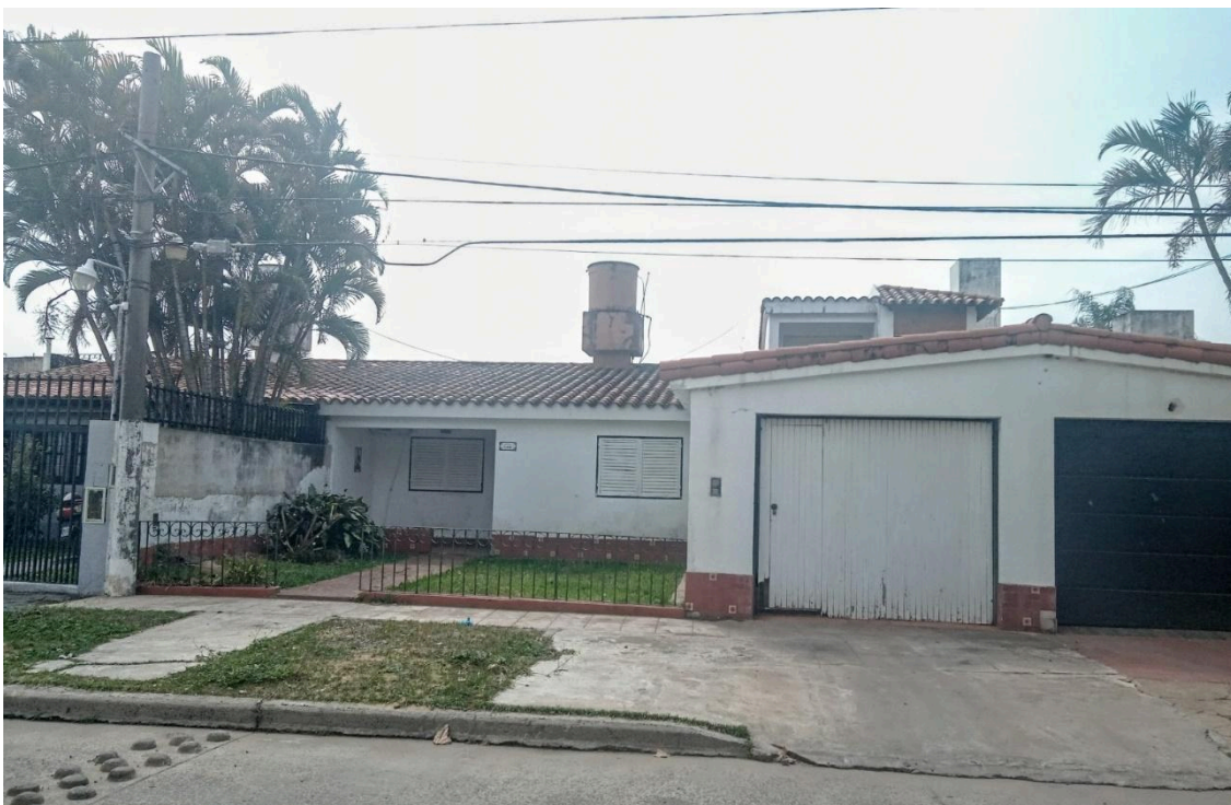
Figura 3: Vivienda del barrio Apipé en estado original.
