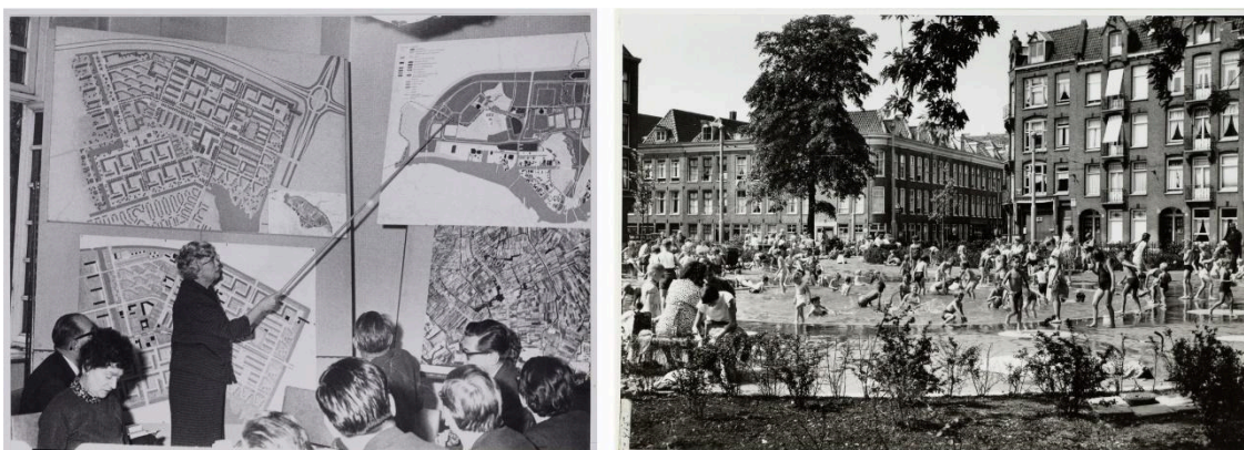
Figura 6: Jakoba Mulder, renovación de Bellamyplein, Amsterdam, 1950.
