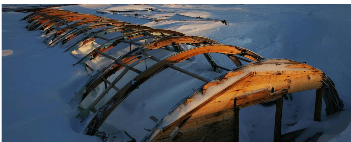
Figura 5: Fotografía de los restos materiales de la Base Wilkes enterradas en el hielo
