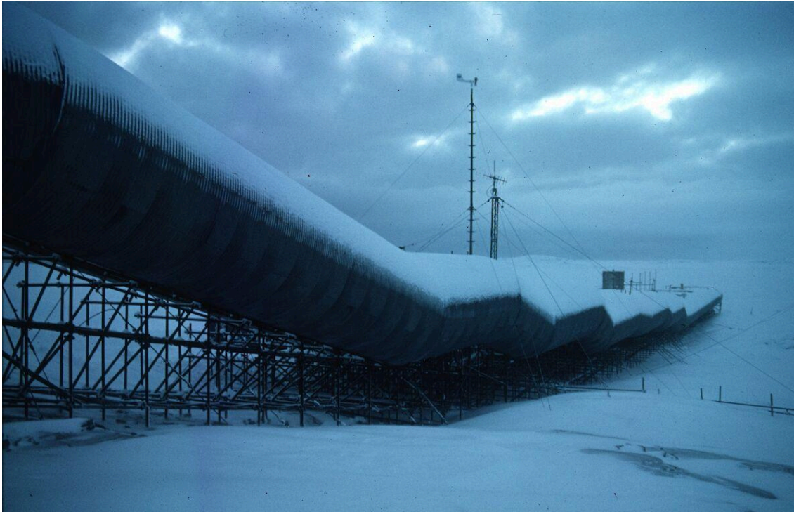
Figura 2: Fotografía del túnel de Casey Repstat
