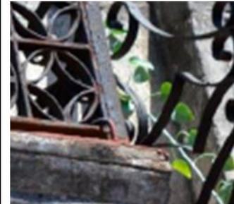
Detección de iniciales procesos de corrosión, fisuras y desprendimiento de material en el anclaje, ..
