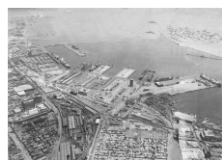
Figura 9: Terminal Portuario 2001. Fuente: Portal Web Mundo Marítimo.
