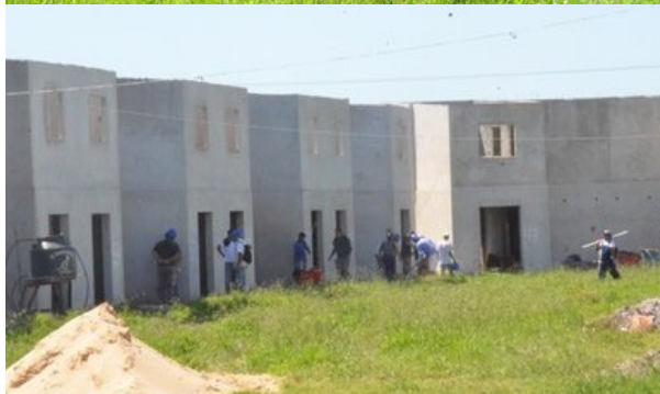
Imagen7 y 8. Finalización del barrio de 104 Vivienda
