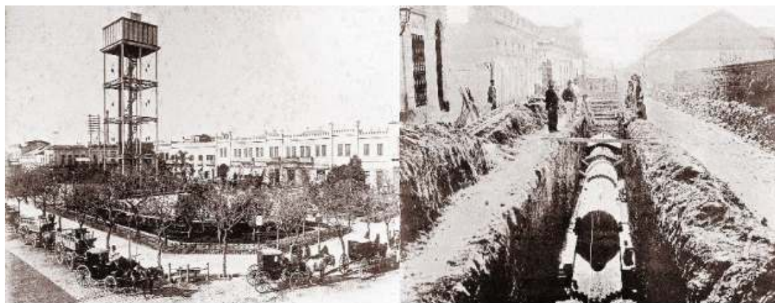
Figura 3. Primeras obras, depósito de hierro en ex Plaza Loria y cañerías conductoras (1869).
