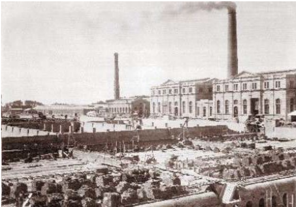
Figura 4. Construcción Planta San Martín (1913).
