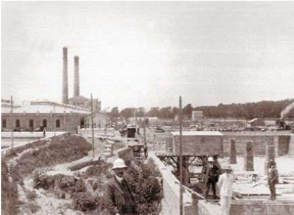
Figura 5. Construcción Planta San Martín (1913).
