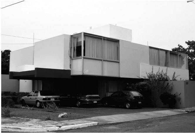
Figura 7: Fachada de la casa Casares Cámara (1970). Fuente: Archivo Elvia María González Canto.
