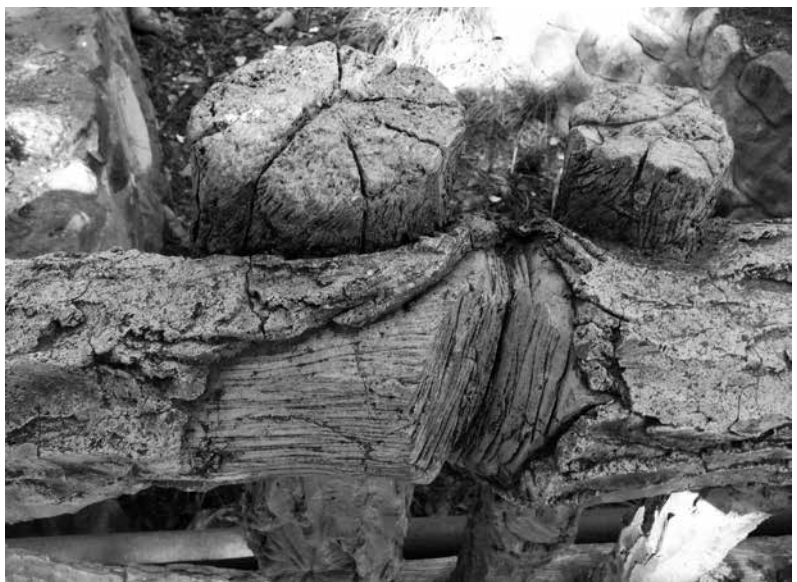
Figura 4: Detalle donde se observa hasta qué nivel de minuciosidad se lograba imitar la naturaleza con el cemento. Fuente: Colección Daniel Schávelzon, 2014. J. Gelfo, 2013.
