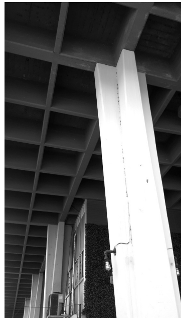
Figura 11: Detalle del basamento, las columnas y los casetones del Hotel de Turismo y Caja de Previsión Social, provincia de Formosa, Argentina, grupo URBIS (1970). Fuente: Fotografía de Ricardo Panero.
