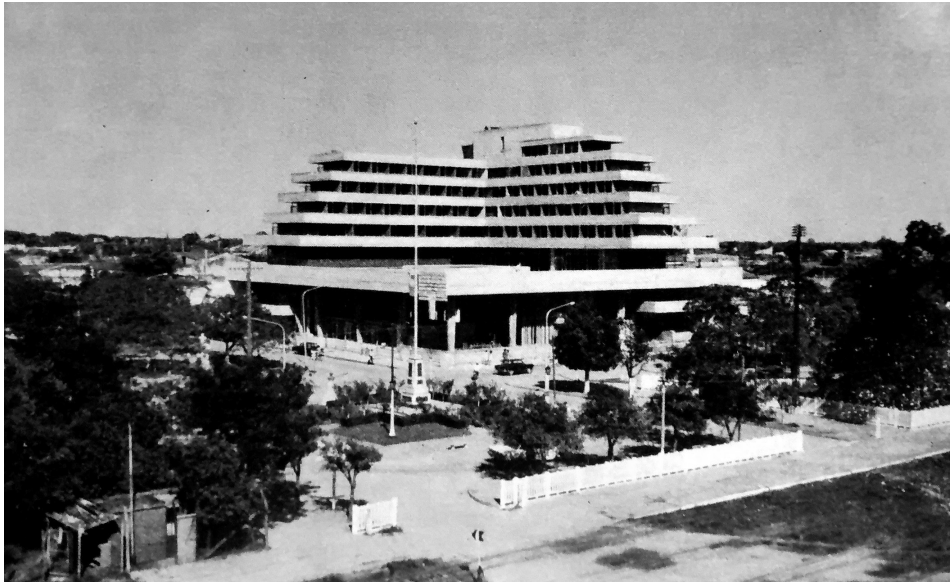
Figura 1: Vista panorámica de conjunto del Hotel de Turismo y Caja de Previsión Social, provincia de Formosa, Argentina, grupo URBIS (1970). Fuente: Summa , 1971, 35, pp. 46-48.
