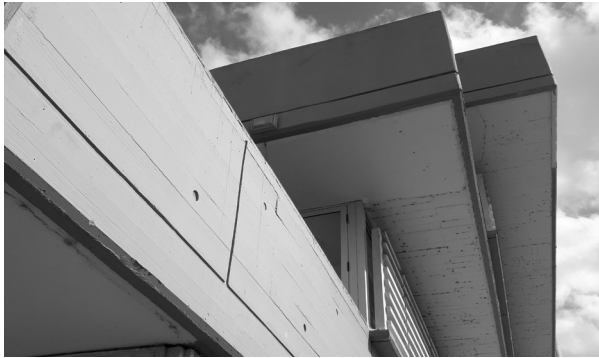
Figura 7: Detalle del hormigón visto y de los voladizos de las alas del Hotel de Turismo y Caja de Previsión Social, provincia de Formosa, Argentina, grupo URBIS (1970). Fuente: Fotografía de Ricardo Panero.
