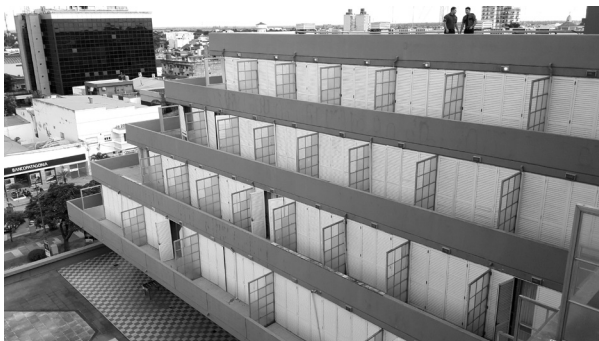
Figura 10: Vista aérea del ala sur del Hotel de Turismo y Caja de Previsión Social, provincia de Formosa, Argentina, grupo URBIS (1970). Fuente: Fotografía de Ricardo Panero.
