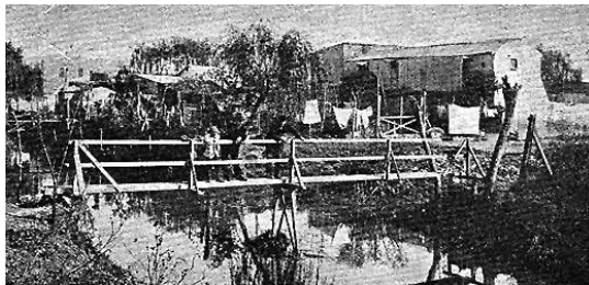
Figura 10: Construcciones precarias sobre el arroyo Vega hacia 1920. Fuente: Archivo General de la Nación.
