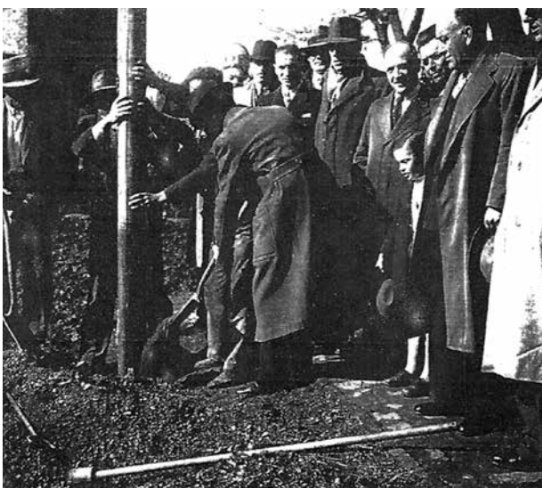
Figura 5: Vecinos de Martín Coronado trabajando en el tendido eléctrico. Fuente: Archivo Sociedad de Fomento Martín Coronado.
