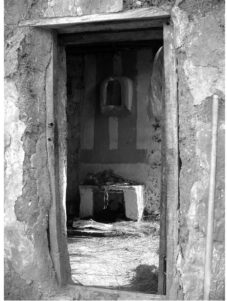
Figura 9: Detalle de la hornacina y del altar en un oratorio de Rinconada. Fuente: Fotografía de los autores.
