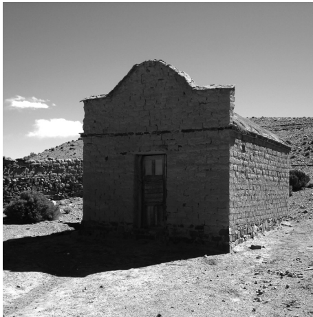
Figura 6: Muro prolongado verticalmente con el tratamiento a modo de espadaña, en los alrededores de Susques. Fuente: Fotografía de los autores.
