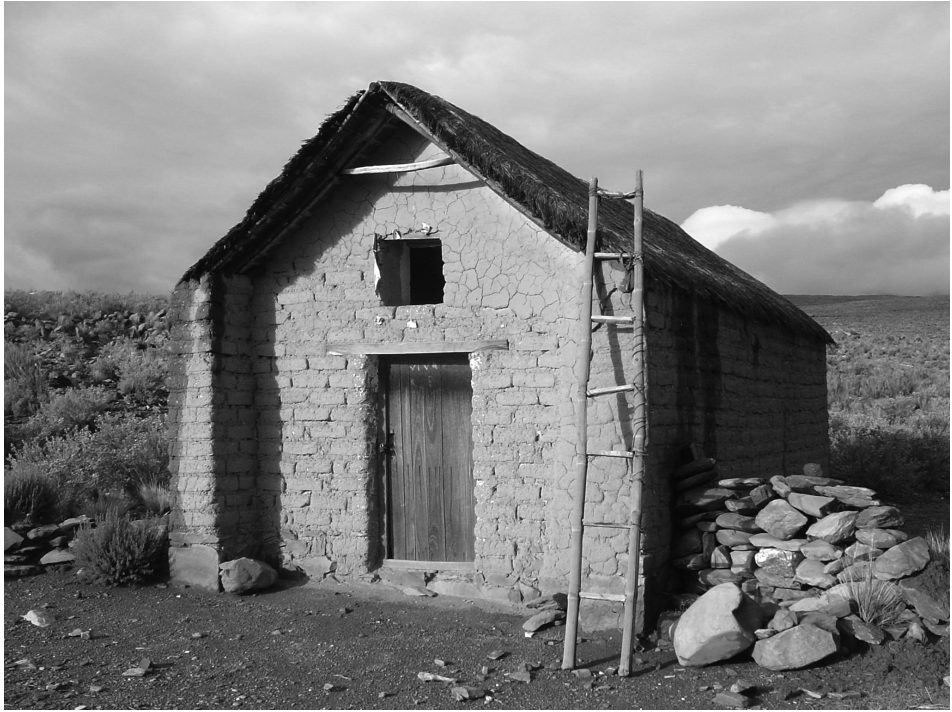
Figura 5: Oratorio en Rinconada, con sus muros en avance que conforman la antecapilla, y la ventana por encima del acceso. Fuente: Fotografía de los autores.
