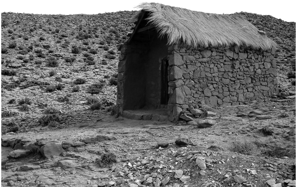
Figura 10: Oratorio enteramente construido en piedra con techado de guaya en Susques. Fuente: Fotografía de los autores.
