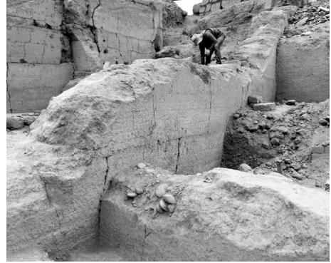
Figura 9: La regularidad con la que se presentan las fisuras verticales de los largos tramos de muro ha hecho pensar erróneamente que se trata de piezas modulares de tapia. Huaca Bellavista, Lima, Perú. Fuente: Fotografía del autor.
