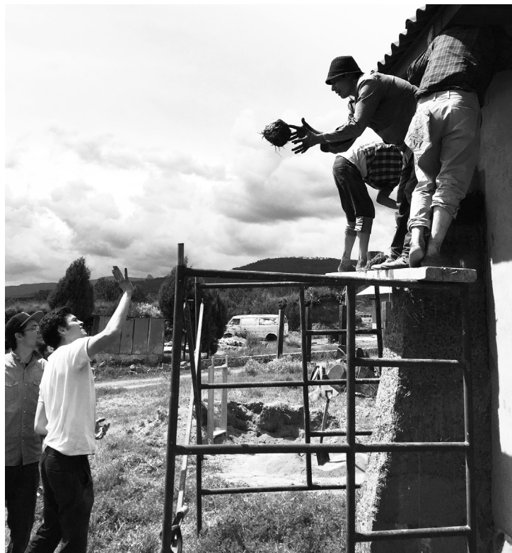
Figura 4: Práctica de construcción con esferas de barro modeladas y posteriormente compactadas. XIV Congreso Internacional de Arquitectura en Tierra. Tradición e Innovación. Tlaxco, Tlaxcala, México. Fuente: Fotografía del autor.
