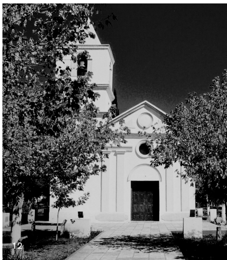
Figura 12: San José, Campanas. Fuente: Fotografía de los autores.
