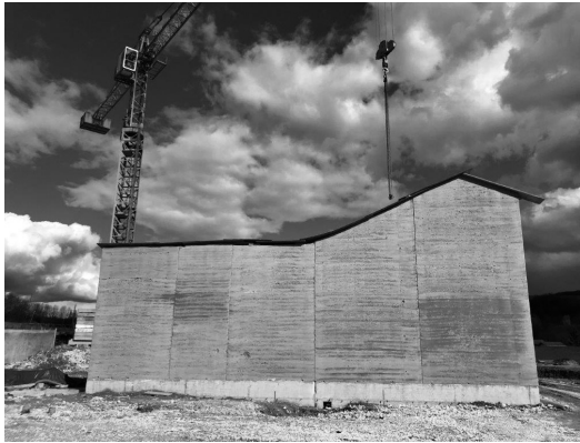
Figura 13: Primeros muros del grupo escolar de la Haute Herbasse en Miribel (Drôme). Fuente: (Nama Architecture, 2018).
