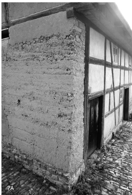
Figura 6: Intervención en vivienda de tapia, Castilla y León, España. Fuente: (Correia, 2011).
