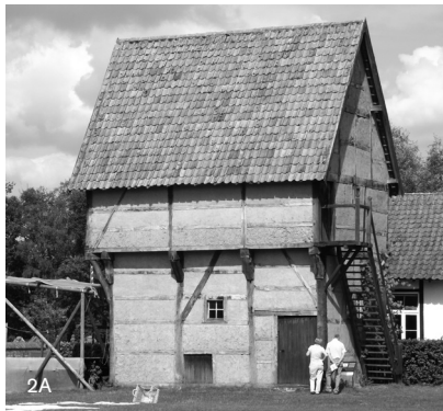
Figuras 2A y 2B: Técnica mixta de encestado integrado en estructura de madera, Museo de Bokrijk, Bélgica. Fuente: (Correia, 2010).
