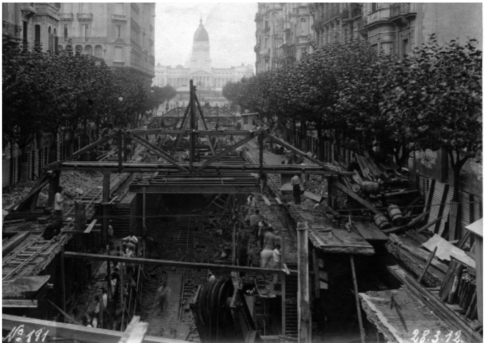
Figura 2. Vue des travaux dans l' Av. de Mayo depuis Santiago del Estero vers l' Ouest. Autor Anónimo. Fuente: Gutman. 1999.
