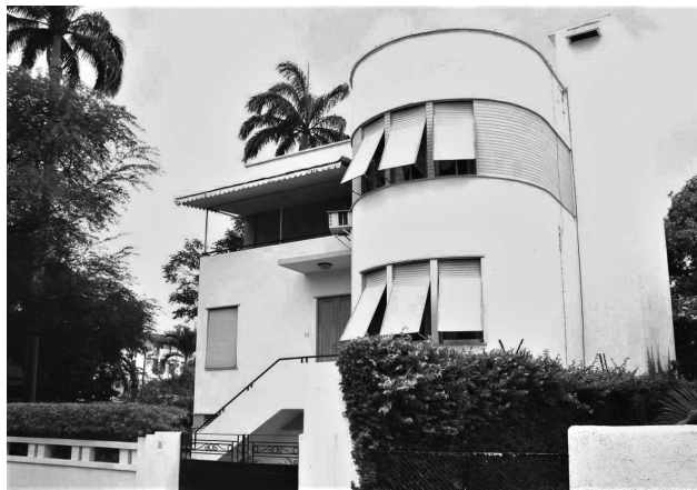
Figura 9: Casa Solá, Argüelles 113 y Maracaibo, Guayaquil (1938). Fotografía (2010). Fuente: Archivo Florencio Compte.
