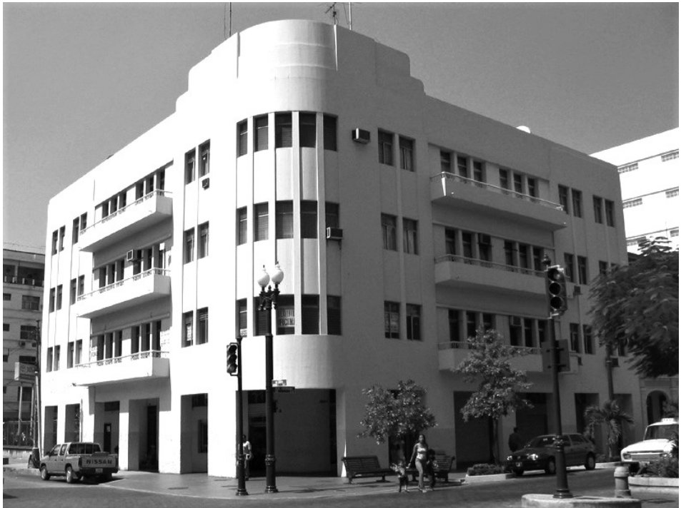
Figura 11: Edificio Vincenzo Andretta, Nueve de Octubre y Avenida del Ejército, Guayaquil (1939). Fotografía (2011). Fuente: Archivo Florencio Compte.
