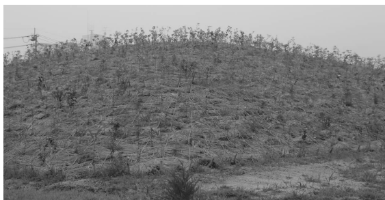
Figuras 2 y 3: Bosque de mitigación en la ciudad costera de Iwanuma, Japón. El proyecto forma parte del plan de reconstrucción urbana, post tsunami de 2011. Como se observa en la sección, el bosque se desarrolla sobre un sistema de colinas artificiales levantadas a partir de la acumulación de escombros generados por el tsunami. Fuente: Plan de Reconstrucción para Iwanuma. Renaud y Murti, 2013.
