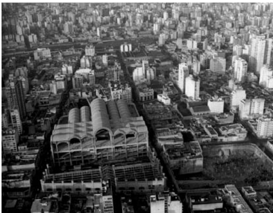
Figura 10. Vista aérea del Abasto luego de los trabajos de construcción realizados por El Hogar Obrero. Esta fotografía fue parte de la documentación presentada en el remate de las acciones de SAMAP. Fuente: Archivo El Hogar Obrero (EHO)
