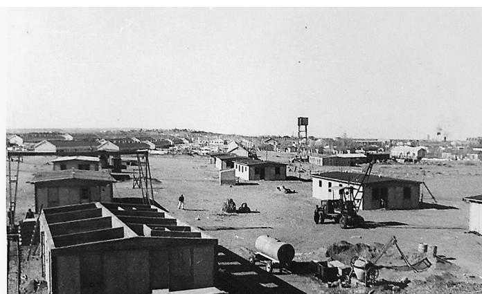
Figura 11 Montaje de viviendas con el sistema de Sofer en Plaza Huincul. Fuente: Sofer (1949).
