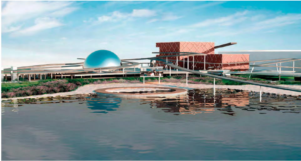
Figura 4A Vista desde el lago hacia la ciudad, mostrando la fachada frontal del teatro del lago. Fuente: elaboración propia.
