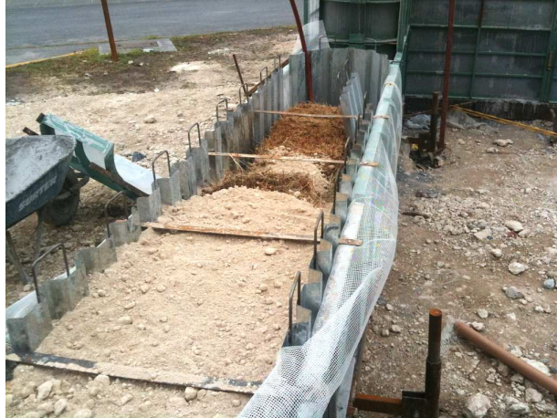
Figura 1. Muro relleno de paja y tierra
