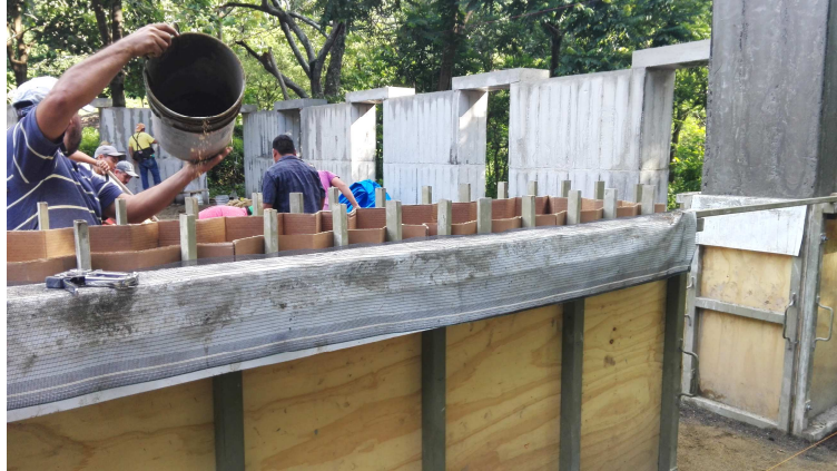
Figura 5. Molde en proceso de relleno de tierra.
