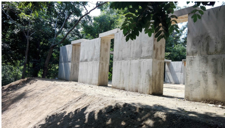
Figura 7. Muros terminados y ensamblados con dintel.
