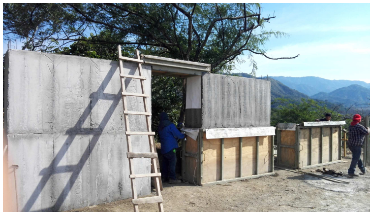
Figura 6. Desmoldado de los bloques.
