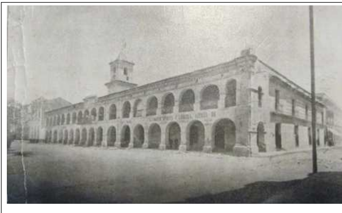
Figura 1. Fachada del Cabildo ca. 1880, previa a la demolición de la esquina del ángulo Noroeste.
