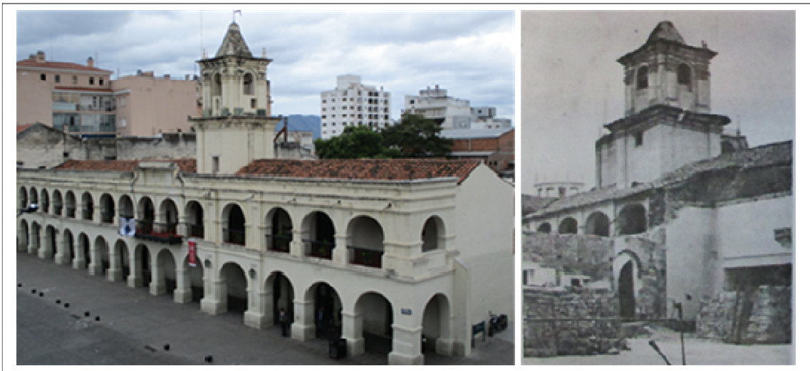
Figura 3. Fachada principal hacia la Plaza 9 de Julio - Figura 4. Patio Mayor (NO) durante la restauración
