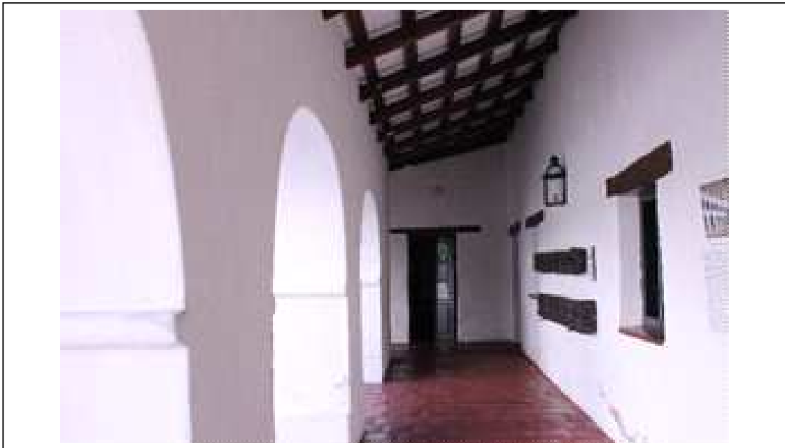
Figura 5. Detalle de la recova oeste del patio mayor.
