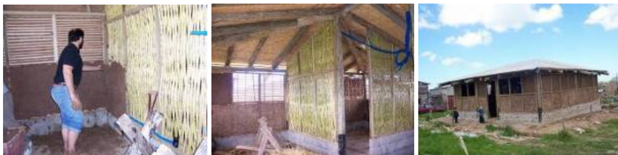
Montevideo – Construcción Prototipo en Fajina – año 2005
