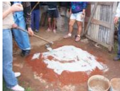
Adición de cemento
