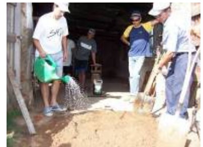
Adición del agua
