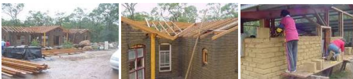
Australia – Construcción en BTC
