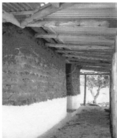
Techumbre v Muro de Terrón
