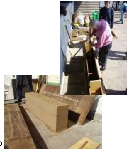
Fabricación de tapial con molde vertical simplificado
