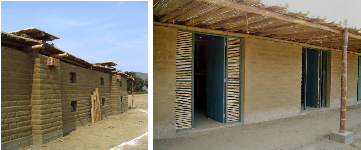
Figuras 16 y 17. Etapas del proceso constructivo aplicando el sistema sismo-resistente a la construcción con tierra.
