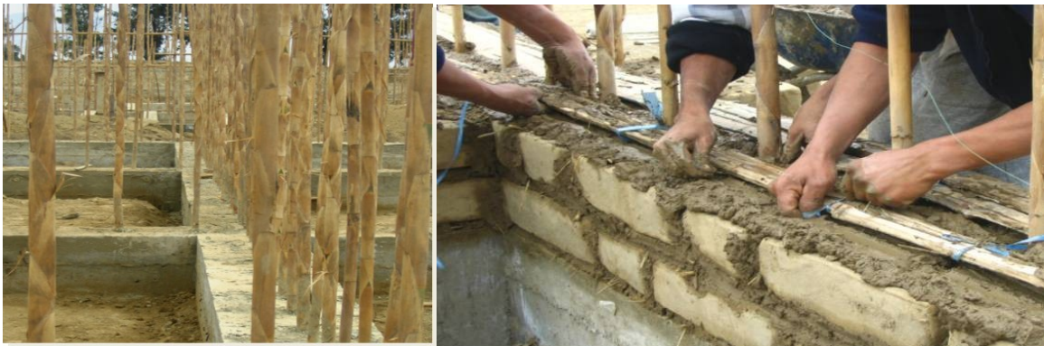
Figura 14. Caña brava empotrados en el sobre-cimiento y ladrillos de tierra cruda.
