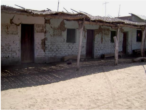
Figuras 10 y 11. Construcciones en tierra después del terremoto, Lima, 2007.
