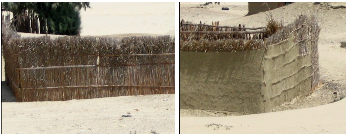
Figura 1 y 2. Caña y tierra. Muros de caña y revestidos en tierra. Desierto de Sechura, Piura.
