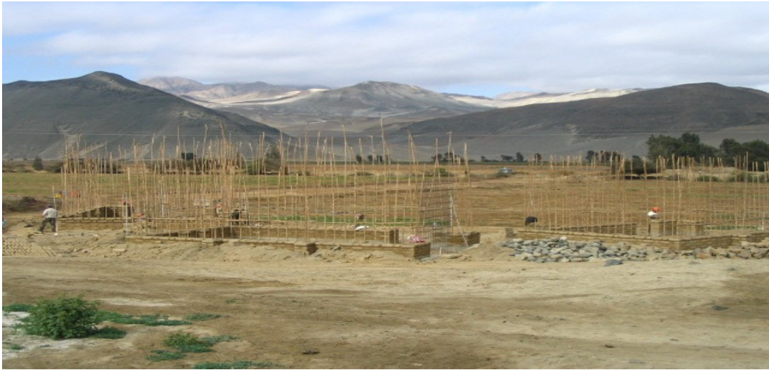
Figura 13. Inicio de la construcción, cimientos y esqueleto interno en Caña Brava, Huarmey.
