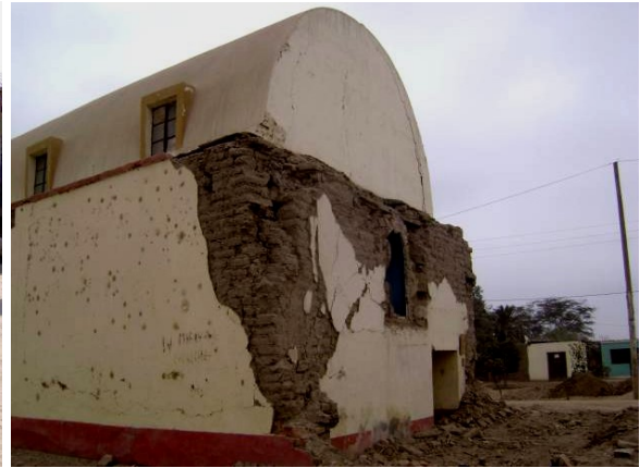
Figuras 10 y 11. Construcciones en tierra después del terremoto, Lima, 2007.
