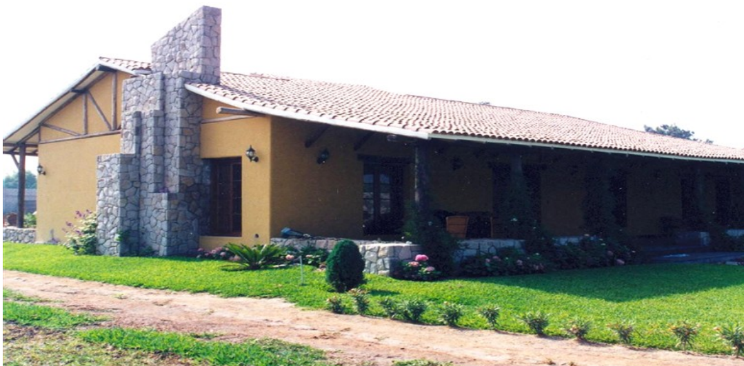
Figuras 18 y 19. Vista exterior de la capilla y vivienda, construcción sismo-resistente en tierra.
