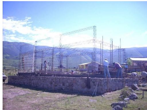
Figura 2. Montaje de la estructura.
