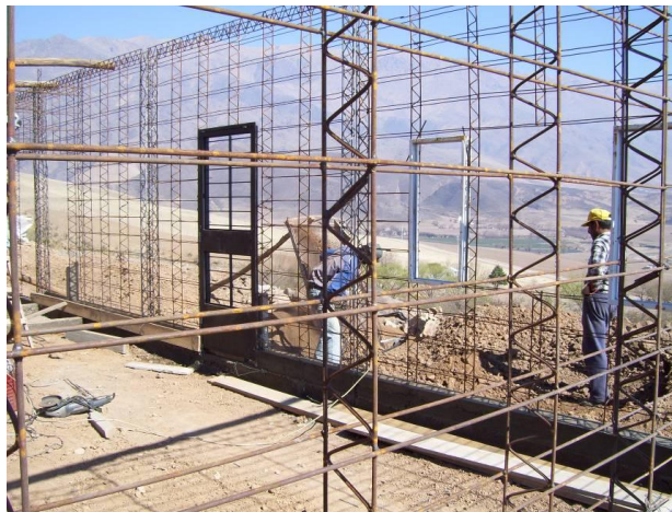
Figura 13. Estructura con retícula plana de hierro.
