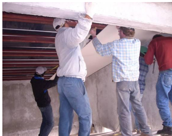
Figura 9. Colocación de cielorraso.
