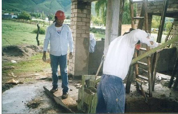
Figura 12. Construcción con BTC.
