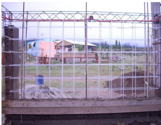
Figura 5. Armado de paneles.
