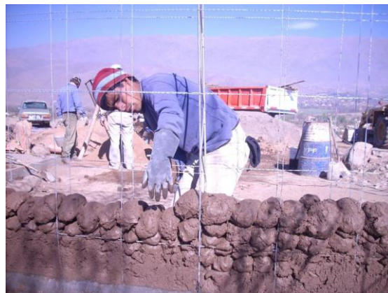
Figura 6. Llenando de paneles.
