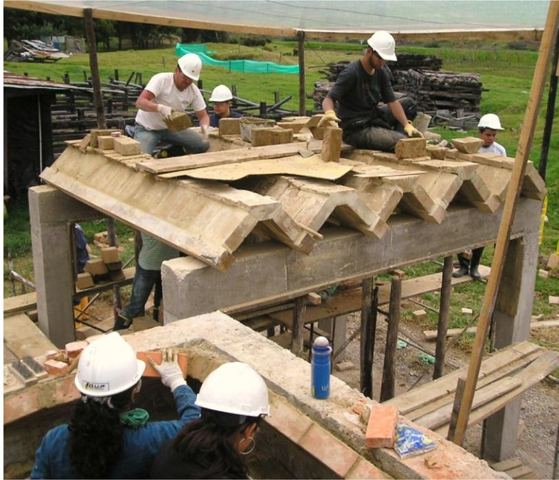
Figura 10. Bovedillas en proceso
