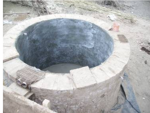
Figura 5 - Construcción cisterna
