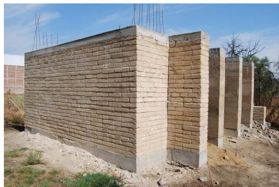
Figura 2. Proceso de edificación en el terreno de las Ánimas, Tulyehualco. (Foto: L. Guerrero)
