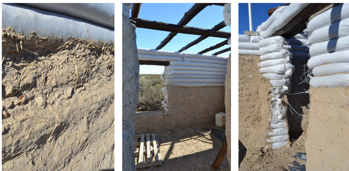
Figura 4. Detalles. Aberturas. Mortero de tierra.
