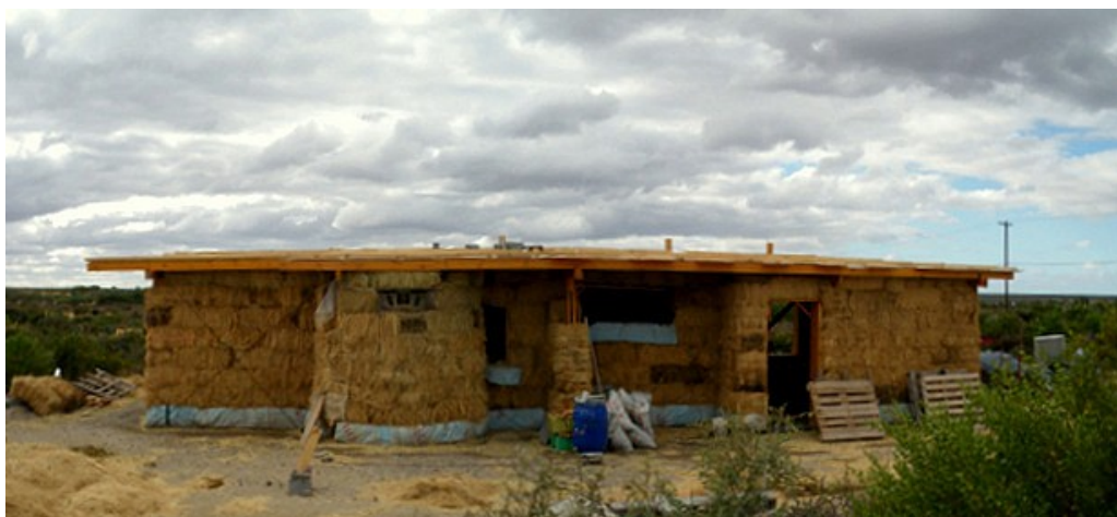
Figura 6. Contrafrente. Fachada Sur.
