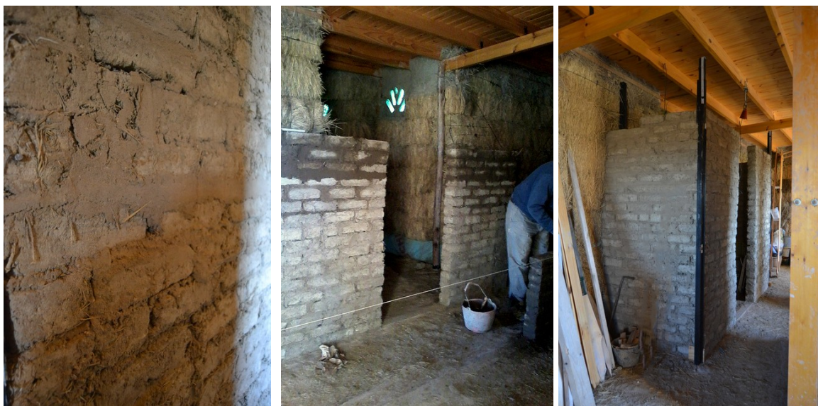
Figura 7. Paredes interiores. Ladrillos de adobe.
