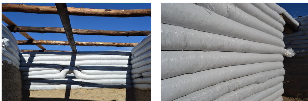
Figura 3. Detalles. Cerramientos y estructura de cubierta.
