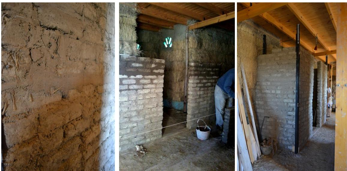
*Figura 7. Paredes interiores. Ladrillos de adobe.*
