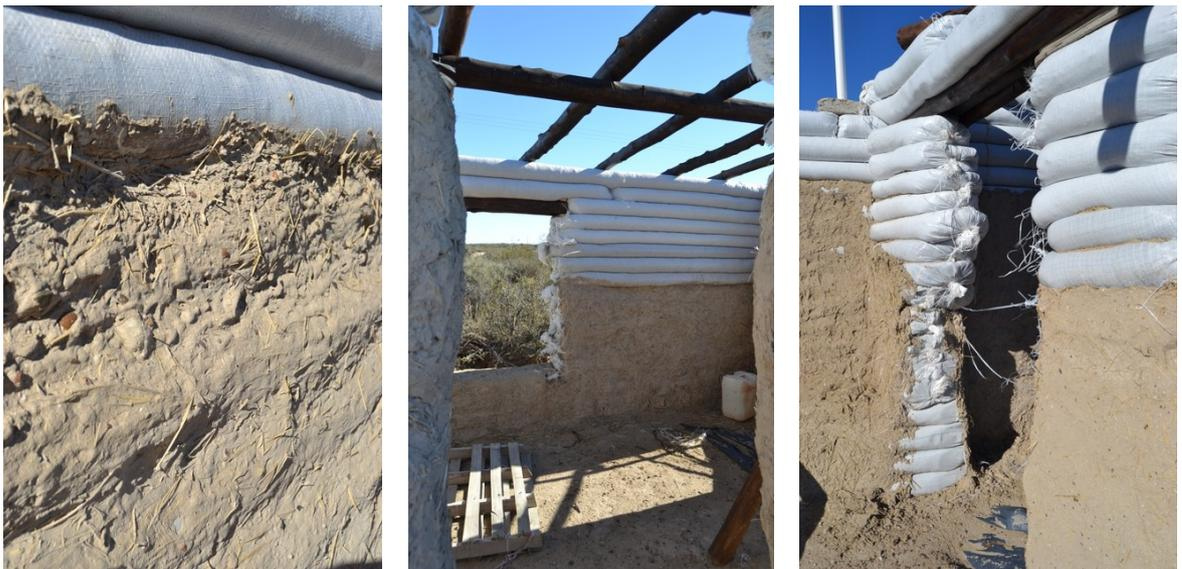
*Figura 4. Detalles. Aberturas. Mortero de tierra.*
