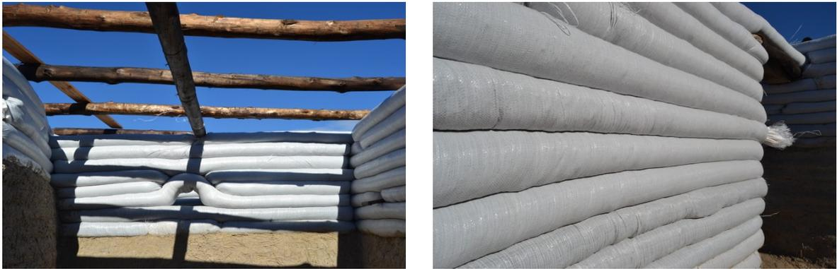
*Figura 3. Detalles. Cerramientos y estructura de cubierta.*
