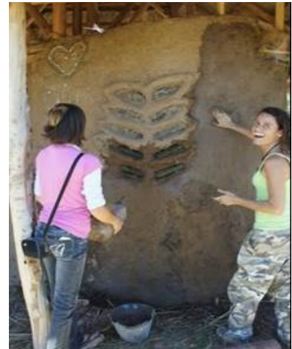
Figura 12. Participantes del taller realizando revoques.
