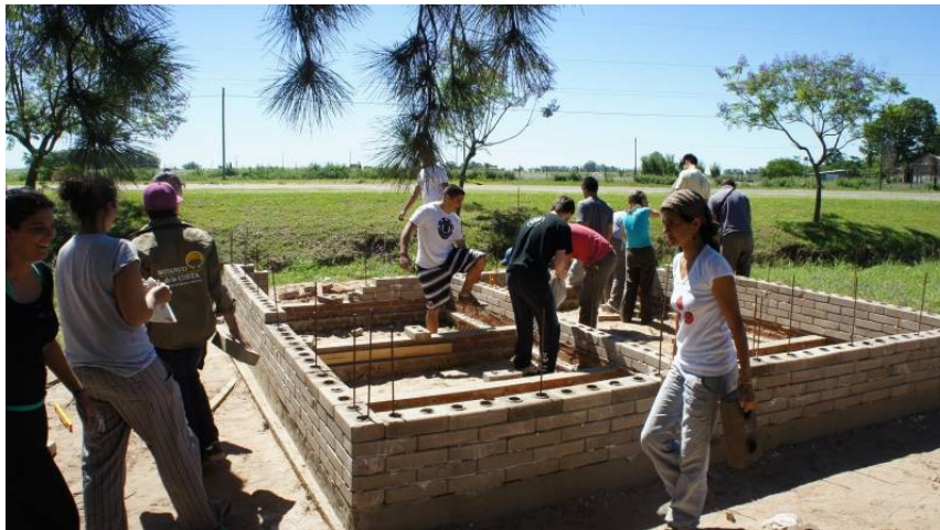
Figura 9. El espacio Obra-Escuela.
