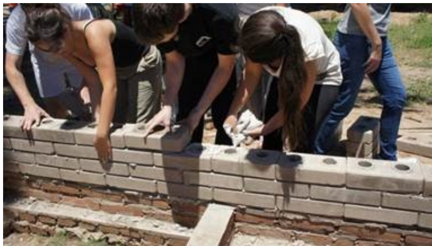
Figura 10. Alumnos universitarios en el programa 'hacer y aprender', trabajando en la construcción de un muro de BTC.
