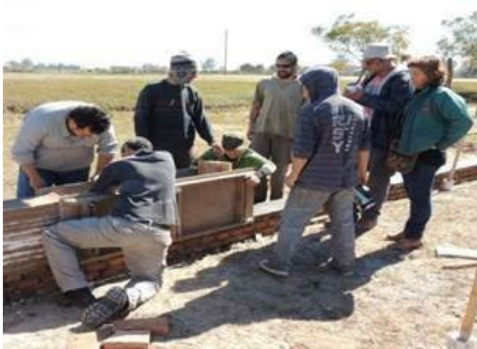
Figura 11. Ejecución de muro de Tapia.
