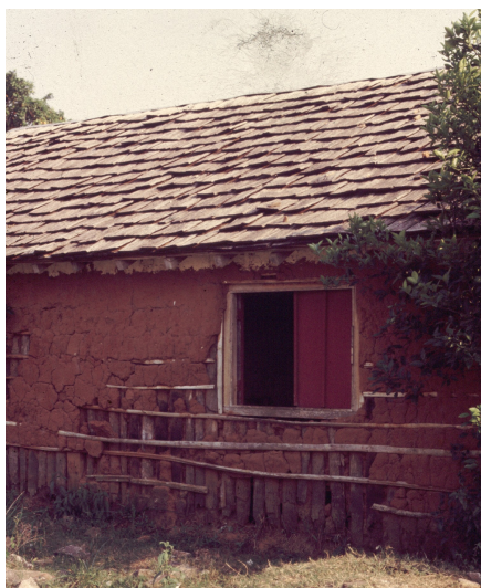
Figura 3. Detalle de vivienda con techo de tablillas y el "estaqueo" a la vista
