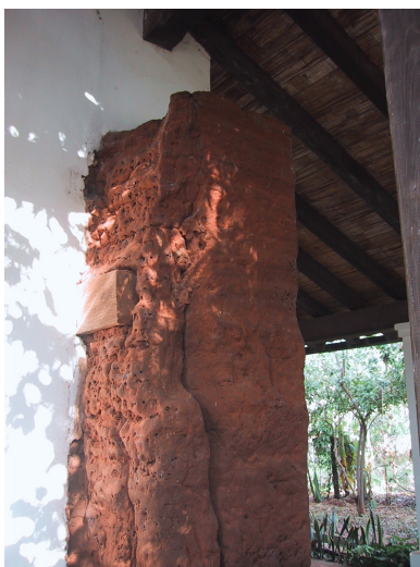
Figura 9. Muros de tapia en San Ignacio Guasú
