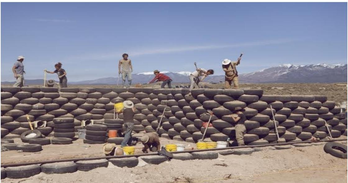
*Figura 3. Paredes de neumáticos llenos de tierra, característica emblemática de los Earthships. Imagen: EarthshipBiotecture.*
